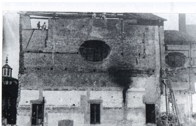
La chiesa di Sant'Eusebio durante i lavori di demolizione, 1921, Musei Civici di Pavia
